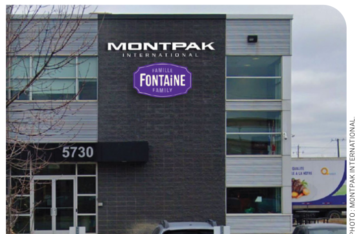
Une analyse énergétique exhaustive a été réalisée dans le but de modéliser avec précision les besoins énergétiques actuels et futurs de l'usine.
