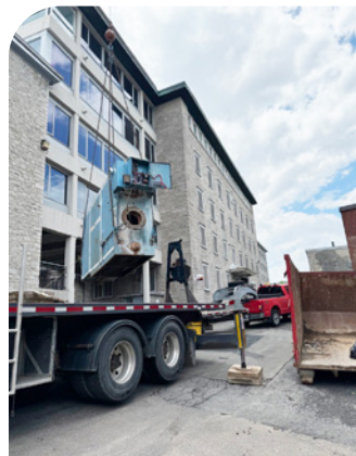
Retrait d'une chaudière à vapeur de l'un des établissements visés.
