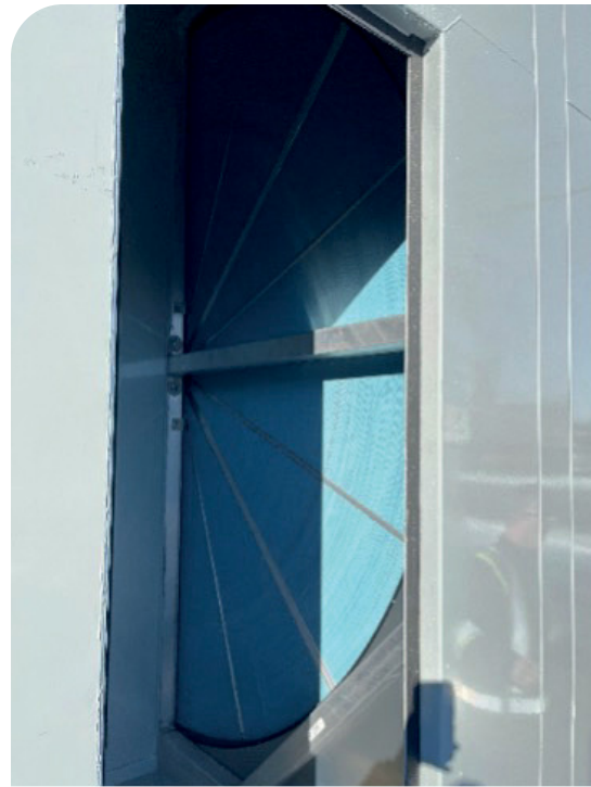
Figure 2b : Roue interne d'aluminium.
