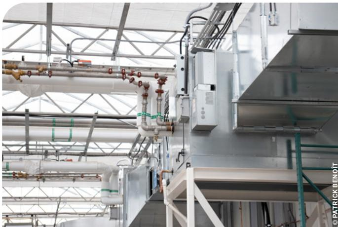
Quatre unités de traitement d'air assurent le conditionnement de l'air ambiant dans la salle de culture verticale, auxquelles sont ajoutées quelques unités servant au chauffage de la serre adjacente.
