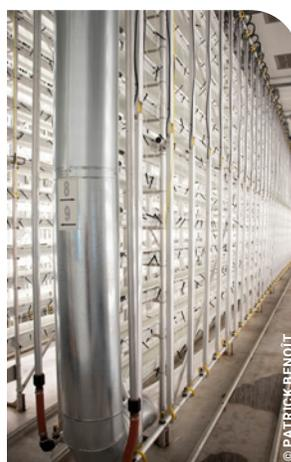
Système d'éclairage à DEL à intensité variable et refroidi à l'eau conçu par Ferme d'Hiver pour remplacer la luminosité du soleil.
