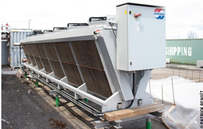
Système de refroidissement adiabatique utilisé pour refroidir l'eau de la boucle du condenseur lorsque la chaleur n'est pas récupérée pour le chauffage des serres adjacentes.
