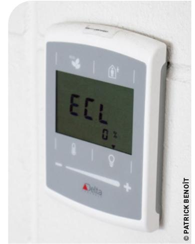
Sonde de CO<sub>2</sub> avec contrôle de l'éclairage, du chauffage et de la climatisation dans chaque classe.
