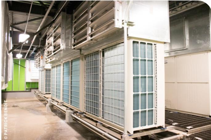
**Vue des sorties d'air d'une partie des condensateurs pour récupérer l'énergie produite par les thermopompes dans l'appentis.**
