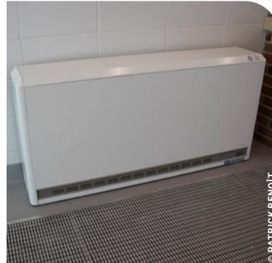
**Accumulateur thermique décentralisé qui chauffe hors pointe l'une des entrées de l'école.**
