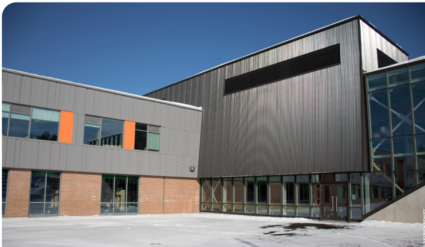
Vue extérieure du mur solaire qui sert pour l'appentis à atmosphère contrôlée sur la toiture, incluant les prises d'air du système de ventilation.
