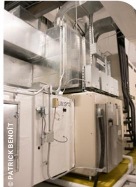
**Centrale de traitement d'air à échangeur de chaleur rotatif avec serpentin DX à réfrigérant variable pour le chauffage et la climatisation, incluant la récupération de chaleur du mur solaire pour les classes.**
