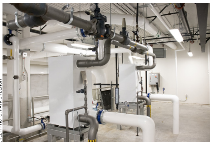
Condenseurs, deux cassettes et échangeurs de chaleur à plaques.
