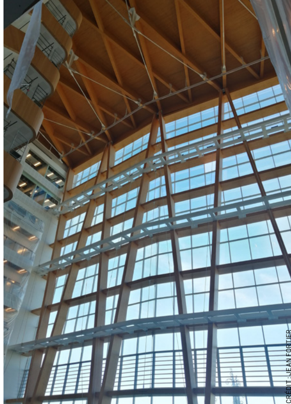
Vue de la façade angulée du mur-rideau en verre de l'atrium et du plafond en structure de bois et d'acier apparents.
