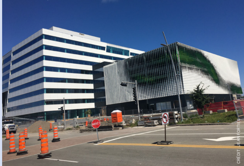
Le revêtement d'aluminium coloré du stationnement crée des ouvertures d'aération et un effet de modulation apparent de l'extérieur, qui en améliore l'esthétique.
