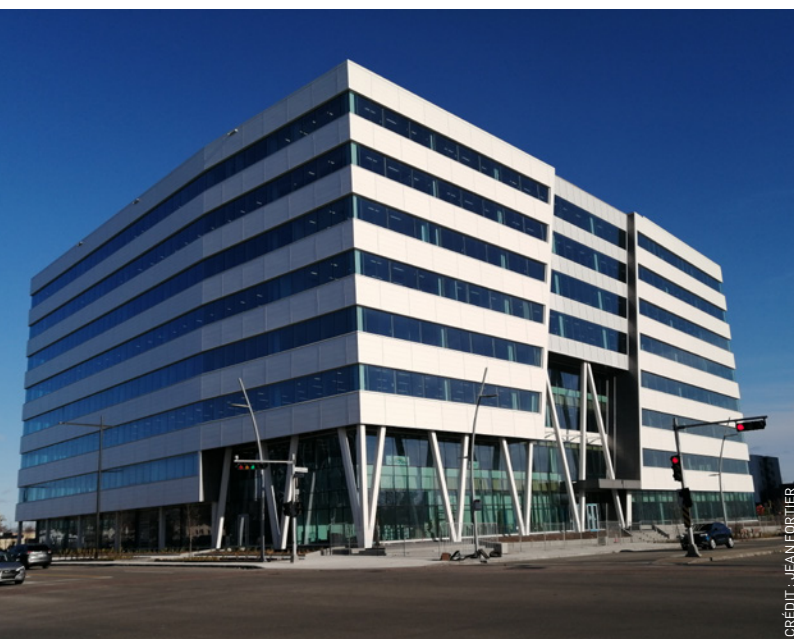
À l'exception de la partie atrium et d'une petite section en mur-rideau à l'avant du bâtiment, l'enveloppe est une composition standard qui permet une isolation thermique performante.
