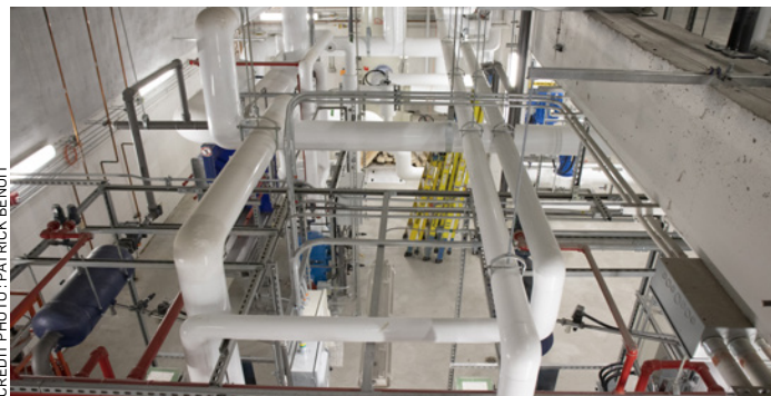
De la salle de contrôle, une fenêtre donne sur la salle des machines. À droite se trouve le plancher de la mezzanine.
