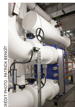
Évaporateur et échangeur de chaleur à plaques, plaques en titane, coiffés par le séparateur tube en U.
