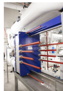
Évaporateur et échangeur de chaleur à plaques, plaques en titane, coiffés par le séparateur tube en U.
