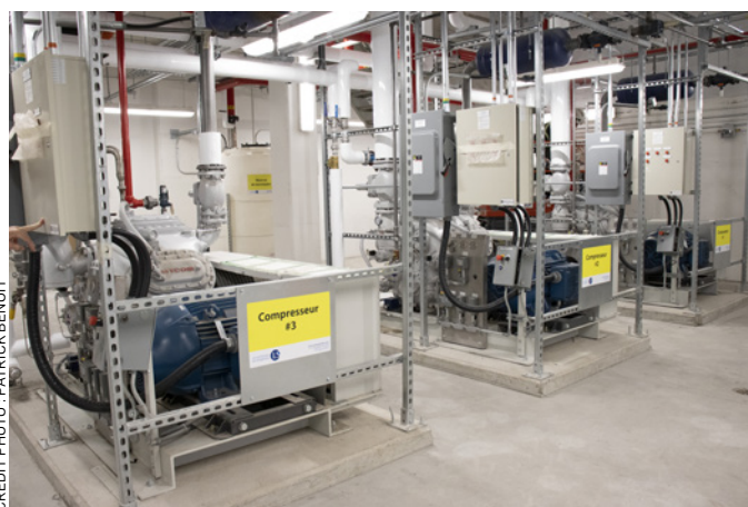
Trois compresseurs de capacité de 59,1 Tr et de 91,9 BHP.
