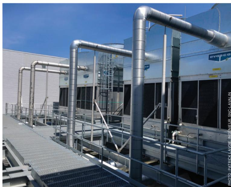
Une deuxième phase prévoit l'ajout de quatre autres tours d'eau dans l'enceinte insonorisée par un mur-écran sur le toit de la centrale thermique.
