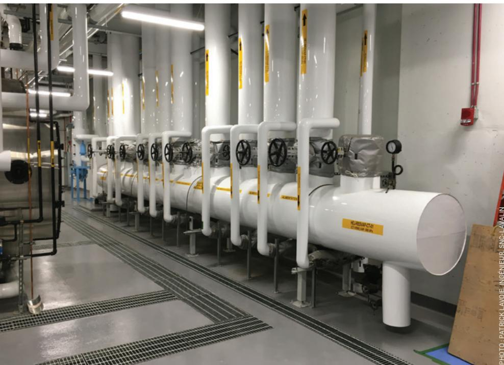
La centrale thermique est équipée d'un imposant réseau de vapeur d'une capacité de 2 100 BHP qui peut répondre à 83 % des besoins en cas de panne ou d'arrêt d'une chaudière.
