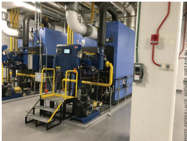
Les quatre chaudières de 600 BHP et les quatre refroidisseurs de récupération de 230 BHP génèrent 105 millions de BTU, soit suffisamment pour répondre à 123 % des besoins de chauffage du complexe hospitalier.
