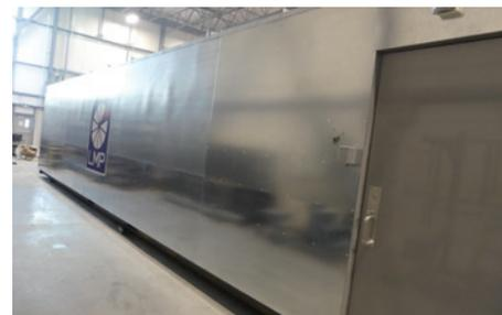
Salle mécanique extérieure permettant de maximiser l'espace d'entreposage. Isolée, chauffée, climatisée et ventilée, prête pour les raccordements de tuyauteries et de l'électricité
