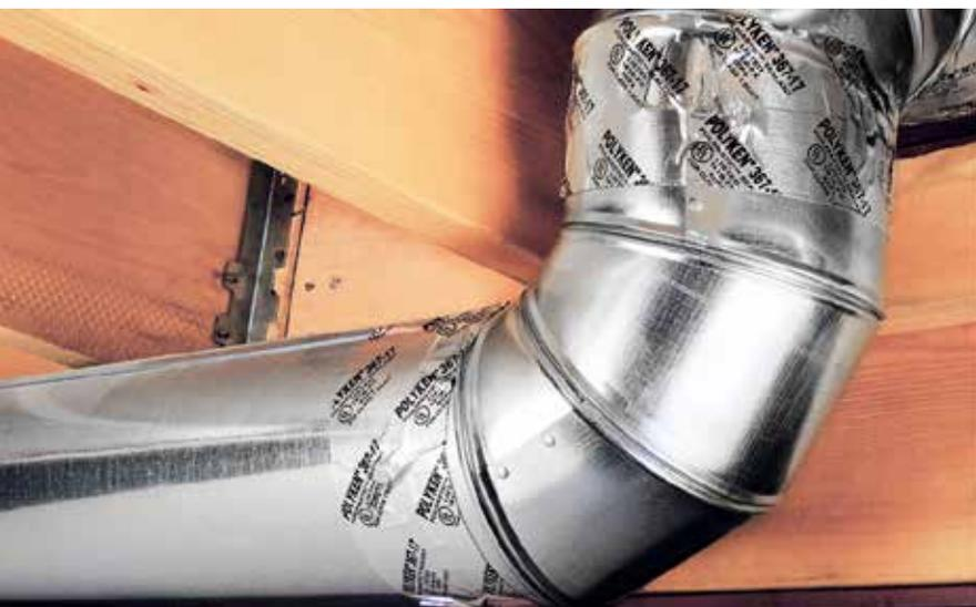
Le duct-tape est l'une des solutions les plus utilisées pour sceller les conduits. Cependant, elle n'est pas la plus efficace.
