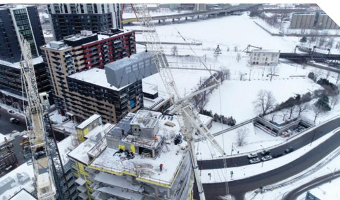
Ascension de la salle mécanique préfabriquée au sommet des quatorze étages.
