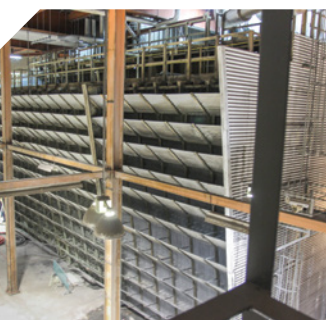
Ancienne tour d'eau datant de 1976
