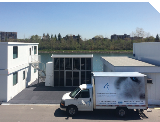
Installation de la climatisation dans les loges hospitalités des pilotes et leur entourage
