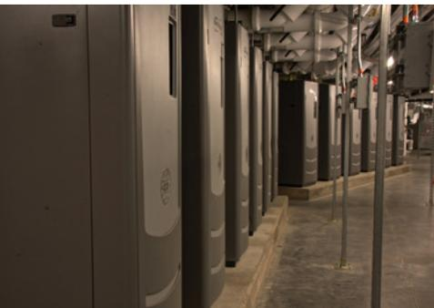
Photo: Salle des chaudières de chauffage à condensation.
