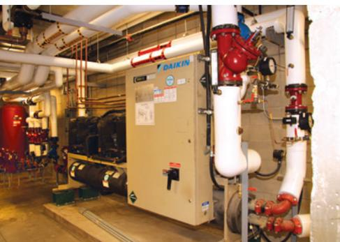
Le système comporte deux refroidisseurs. Celui-ci est utilisé en chauffage.
