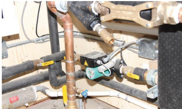
Une des deux petites pompes nécessaires au système de chauffage radiant.
