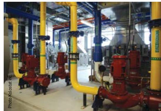
Les pompes des refroidisseurs servent aussi au réseau d'eau glacée.
