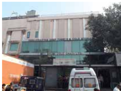
Un des trop peu nombreux entrepôts frigorifiques en Inde
