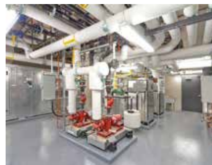
Cette salle mécanique contient le système d'air dédié, les chaudières à condensation et les pompes géothermiques.
