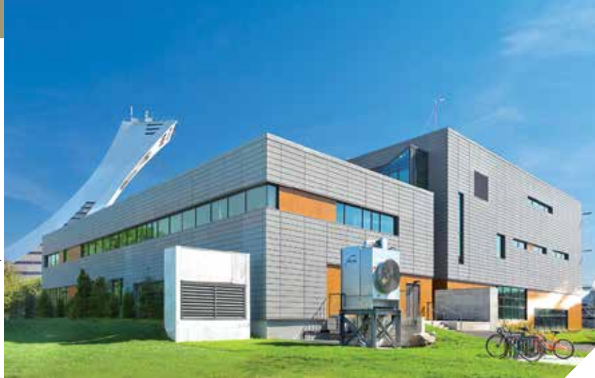
L'énergie provient d'un système géothermique hybride. La géothermie est complétée par un refroidisseur et une tour d'eau.
