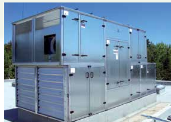
Échangeur à double noyau du garage municipal Val-Morin
