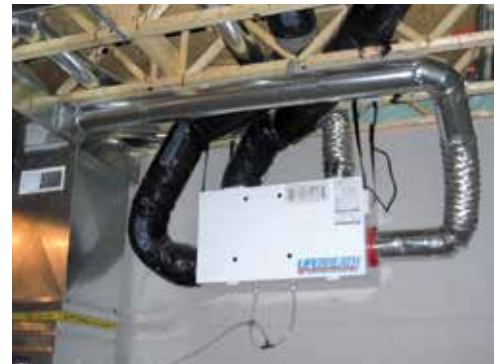
Installation d'un ventilateur récupérateur de chaleur (VRC)
