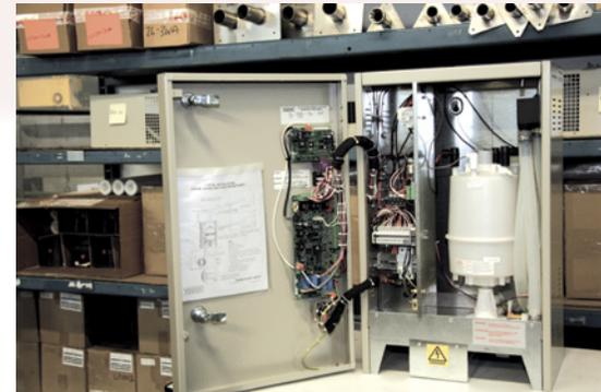
Humidificateur à électrodes
