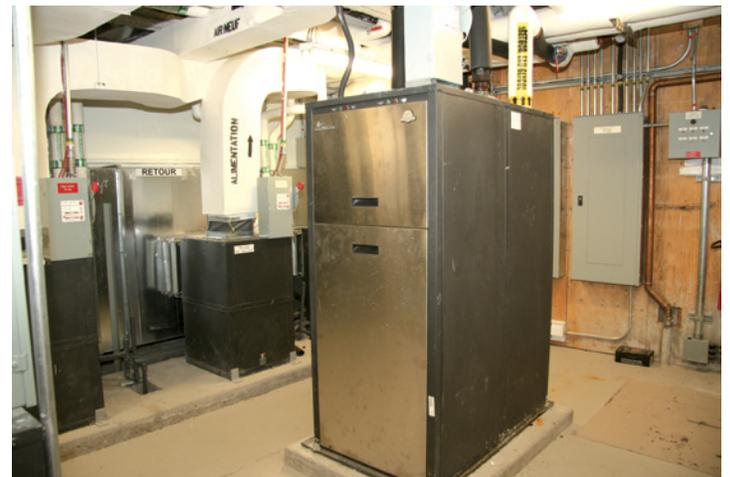
La thermopompe eau-eau est utilisée en préchauffage et refroidissement de l'air neuf.
