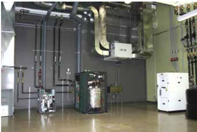
Le Laboratoire de chauffage et ses équipements hydroniques à basse température
