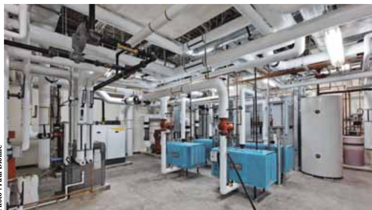
La chaufferie indépendante de la salle mécanique classe T pour la réfrigération à l'ammoniac.
