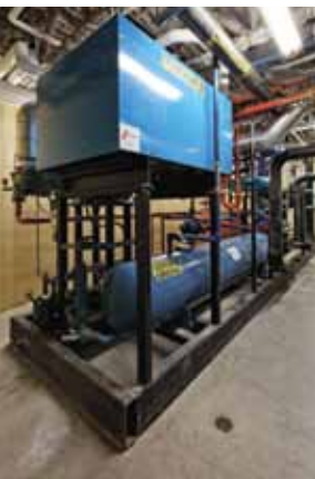
Le désurchauffeur fournit l'eau sanitaire à 140 °F.
