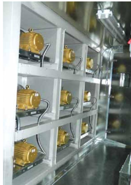
**Le panneau de base est formé de caissons de 34 pouces de côté fournissant 4 000 CFM et utilisant des moteurs variant de 1.0 à 15 HP.**
