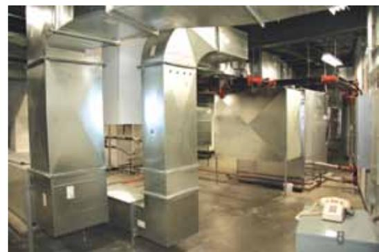
**La salle mécanique : les thermopompes fournissent un débit d'air total de 16 000 l/s et la capacité de climatisation est de 83 tonnes.**
