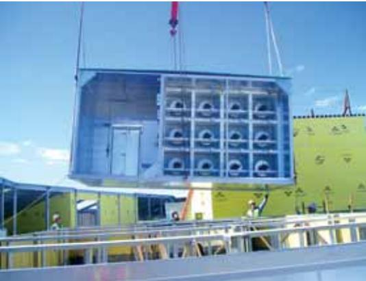
Pour obtenir la capacité de ventilation (jusqu'à plus de 150 000 CFM), il suffit d'ajouter des cubes.
