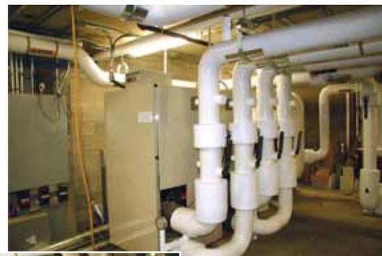
Les deux refroidisseurs de 200 tonnes (ci-contre) et une thermopompe géothermique (ci-haut).
