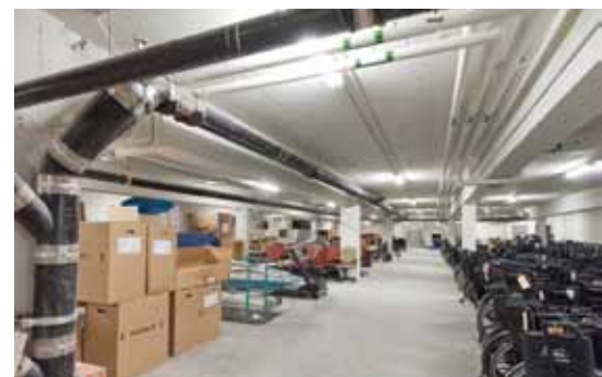
Le remplacement du toit et la mise en place d'une dalle de béton a permis d'éliminer un effet de cheminée nuisible.
