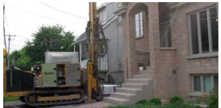
En raison du peu d'espace de terrain, le puits géothermique de 400 pieds a été réalisé par une petite foreuse de 10 pieds de mât.
