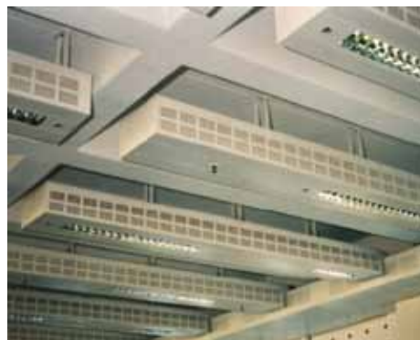
La poutre thermique passive est peu esthétique. Cette option oblige de ventiler et de chauffer avec d'autres équipements.
