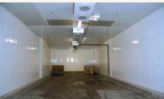
Un des nouveaux réfrigérateurs : les évaporateurs (Refrplus) alimentés au coulis de glace.
