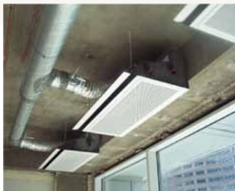
La poutre thermique active est avantagée par de plus petits conduits d'alimentation d'air.
