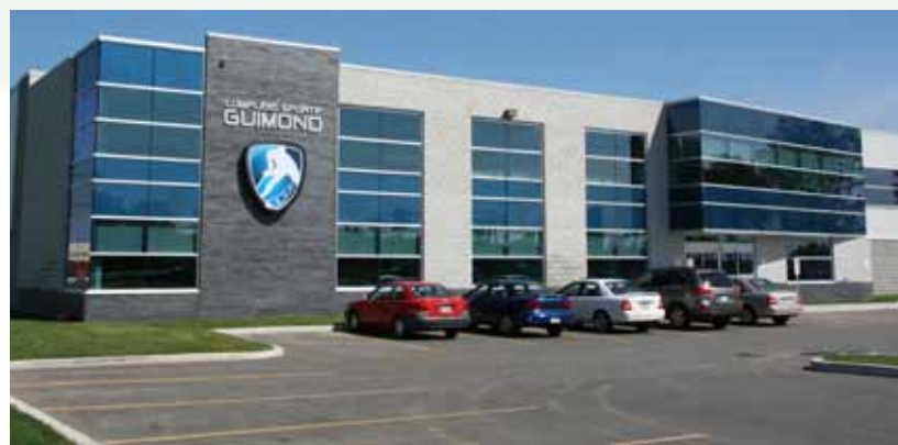
Le complexe sportif Guimond à Laval est équipé d'un système géothermique de cinq puits de 600 pieds et de 25 tonnes de capacité.
