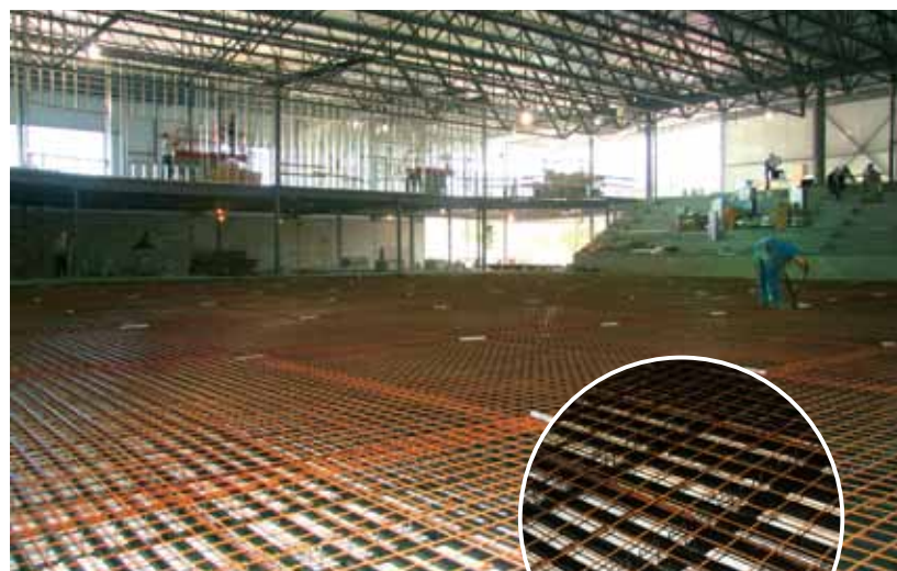
La future patinoire intérieure du complexe sportif Guimond à Laval : la dalle de 85 pi par 200 pi en construction.
