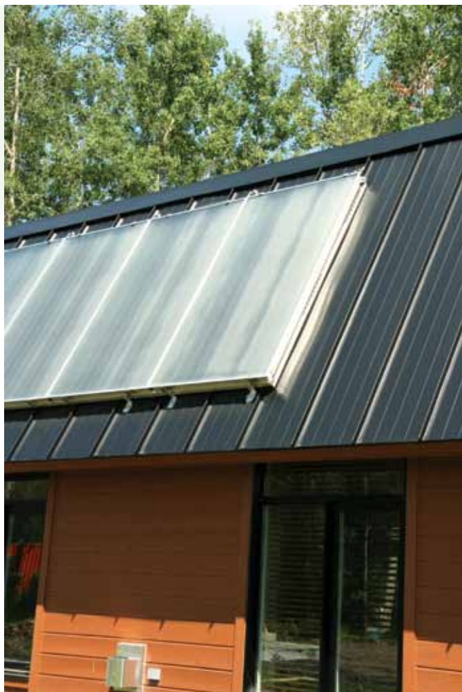
Le capteur plat vitré est très efficace lorsque la température est froide.
