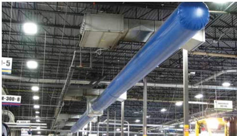
Le Tube NAD rend l'air homogène dans toute la pièce autant en température qu'en humidité.
