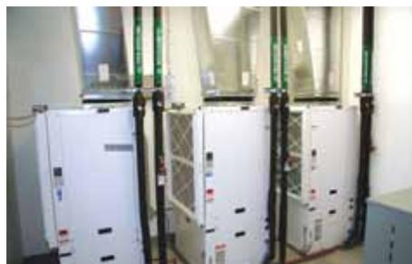
Les thermopompes au réfrigérant R-410 sont logées dans plusieurs salles mécaniques réparties dans le bâtiment.
