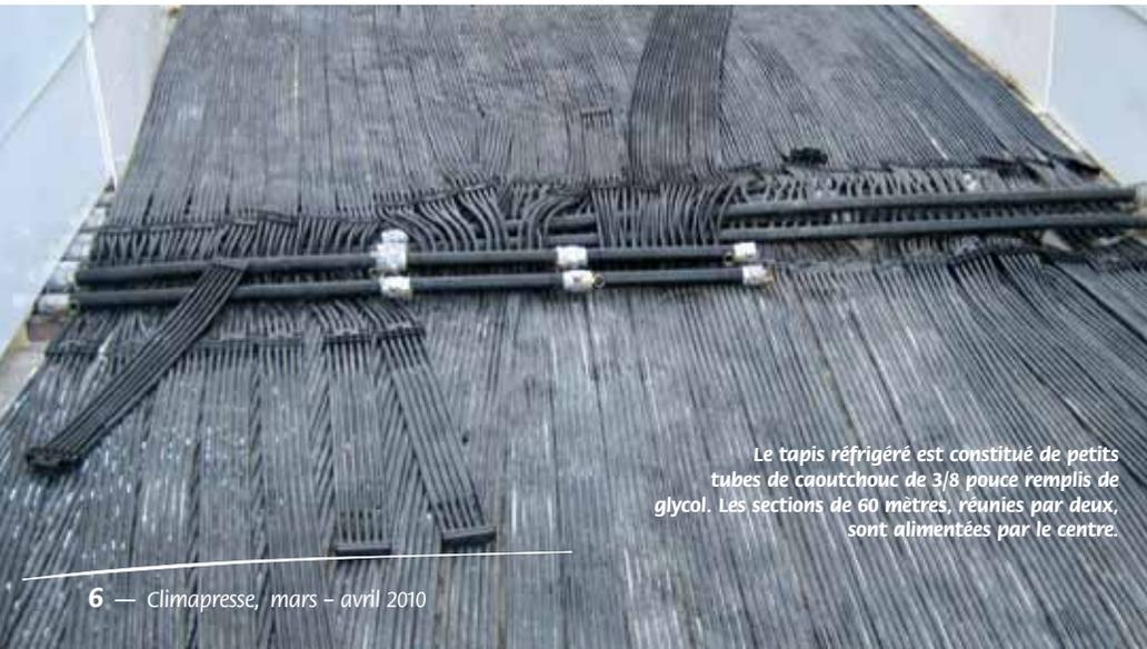
*Le tapis réfrigéré est constitué de petits tubes de caoutchouc de 3/8 pouce remplis de glycol. Les sections de 60 mètres, réunies par deux, sont alimentées par le centre.*
