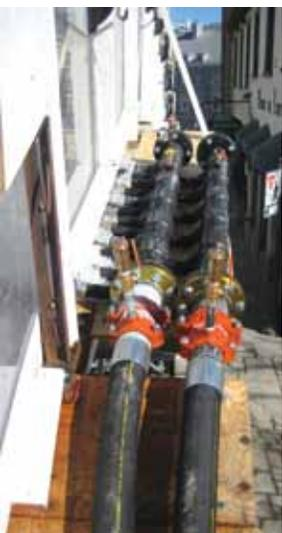
**Loue-Froid a installé trois kilomètres de tuyaux de trois pouces de diamètre et 600 connecteurs.**
