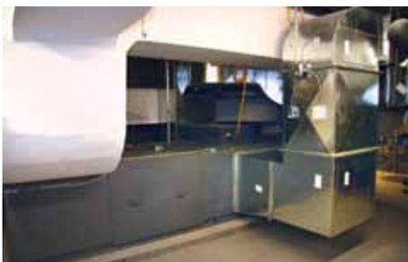
L'échangeur à plaques alternatif possède une efficacité de 90 %.
