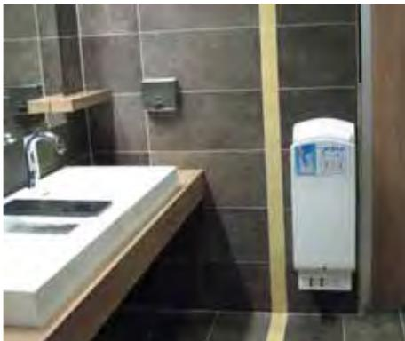
Le sècheur à main à haute vélocité permet la récupération de l'eau dans un réservoir.
