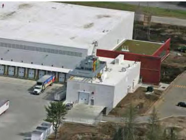
La technologie du thermosiphon est utilisée lorsque la température extérieure descend sous -12 °C. Le gaz tiède du réservoir monte par gravité dans un des condenseurs évaporatifs sur le toit.
