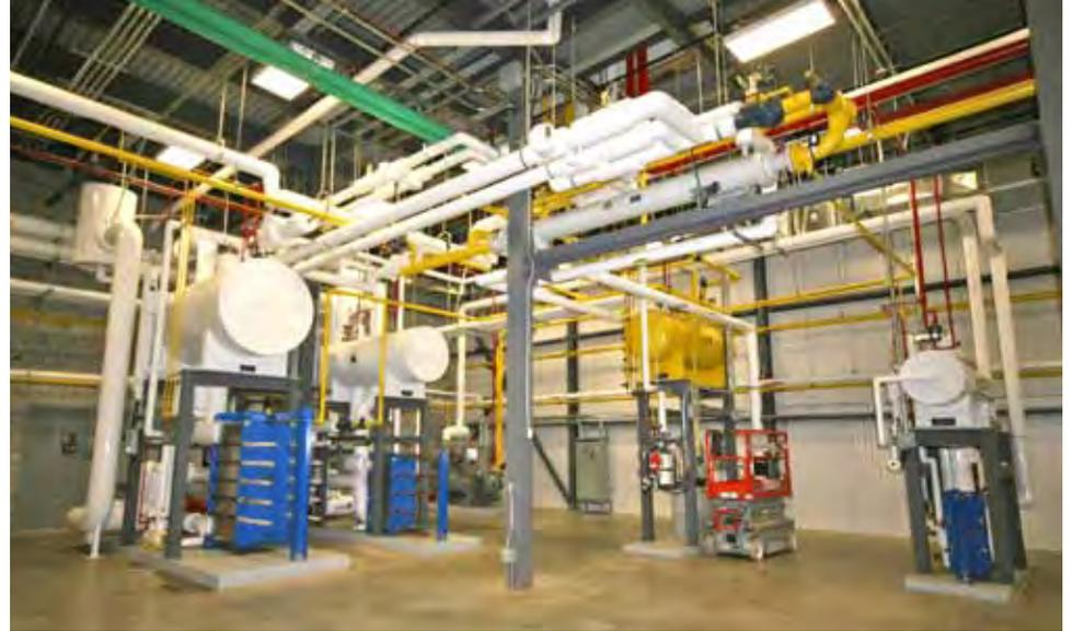
Trois compresseurs à vis totalisant 600 CH (au lieu de 800 CH) ont été installés. Ils fournissent 424 tonnes pour la réfrigération et la climatisation du bâtiment.
