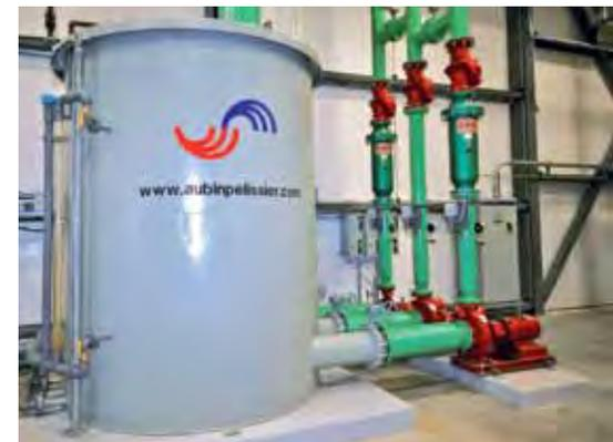
Le réservoir d'eau pour le condenseur évaporatif. La fabrication et l'installation des équipements de réfrigération ont été réalisées par Aubin Pélissier inc.
