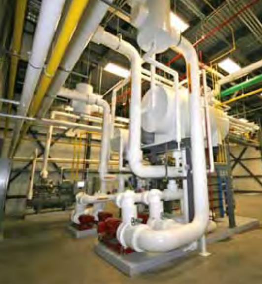
La récupération d'énergie des compresseurs fournit l'eau chaude du système de plancher radiant de la partie administrative du bâtiment.
