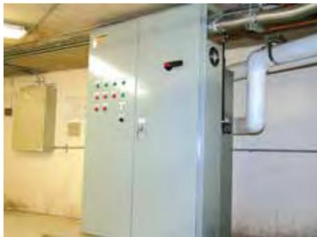
Au plus froid de l'hiver, une chaudière électrique de 235 kW peut être utilisée pour chauffer le réseau de glycol.
